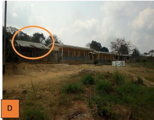
**A, B, C** : habitats démolis par les vibrations lors du dynamitage des pierres, **D** : toiture du CETIC déchirée par les projectiles de pierres lors du dynamitage.
